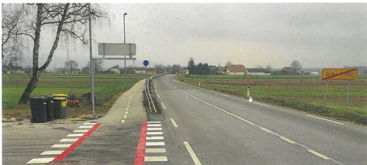
Slika 4: Pogled na izvedeno enostransko dvosmerno kolesarsko stezo ter poškodovano vozišče za naseljem Veliki Podlog proti Pristavi – pogled v smeri stacionaže
